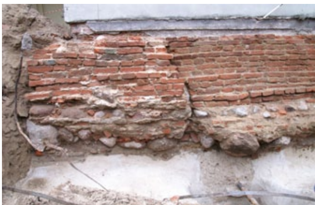
Ryc. 18. Wykop VI, odcinek 2, profil południowy. Wschodnia część fundamentu północnej ściany ryzalitu bramnego. Fot. M. Hrynczyszyn.
