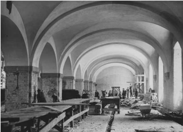
Ryc. 11. Przebudowa Arsenalu na siedzibę Archiwum Miasta Warszawy 1935–38 (NAC).
