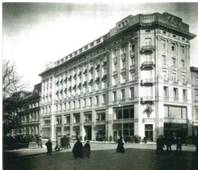
Ryc. 7. Kamienica Heurichowska, widok z 1912 r. („Przegląd Techniczny” 1912, nr 29).
