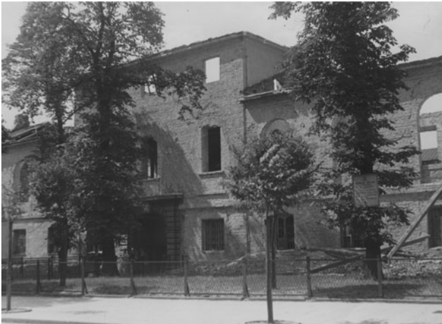
Ryc. 9. Przebudowa Arsenalu na siedzibę Archiwum Miasta Warszawy 1935–38 (NAC).
