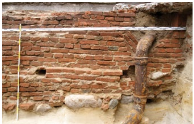
Ryc. 14. Wykop V, odcinek 1. Południowa część zachodniego lica muru 164. Fot. M. Hrynczyszyn.
