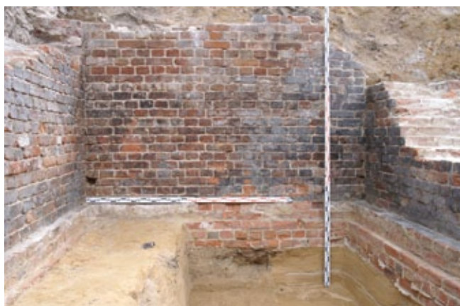
Ryc. 6. Etap I badań. Pomieszczenie nr 18/19, mur 34, widok od północy. Stopa fundamentowa dokumentowanego muru zalega bezpośrednio w calcu. Fot. A. Jankowski. Fig. 6. Phase I of the research. Room No. 18/19, wall 34, view from the north. The footing of the documented wall is located directly on the sterile earth. Photo A. Jankowski.
