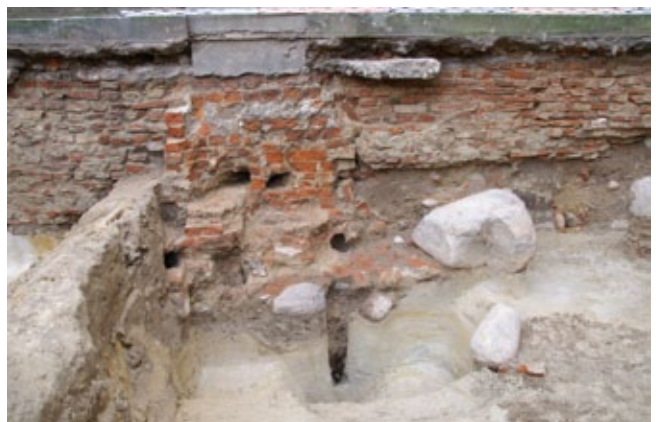
Ryc. 15. Wykop V, odcinek 3, obiekty w profilu południowym. Fot. M. Hrynczyszyn.
