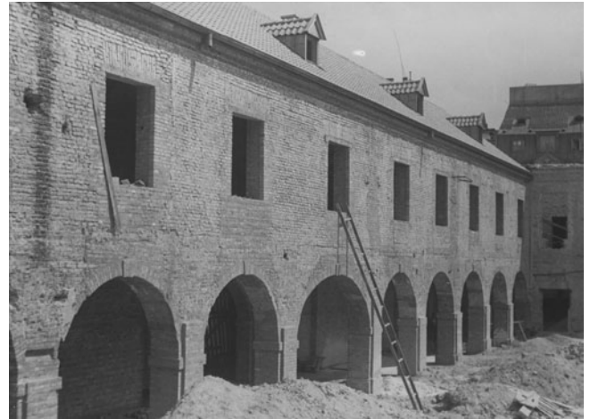
Ryc. 10. Przebudowa Arsenalu na siedzibę Archiwum Miasta Warszawy 1935–38 (NAC).
