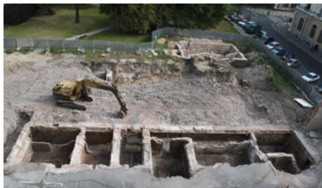
Ryc. 9. Etap II badań. Widok ogólny terenu prac od zachodu. Fot. A. Jankowski.
