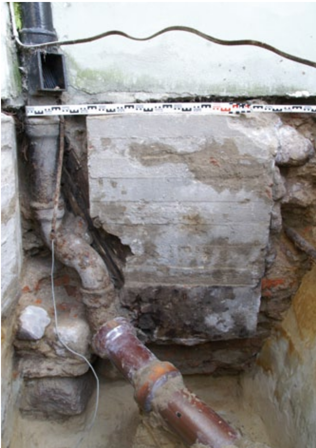
Ryc. 12. Wykop III, odcinek 1, widok od północy. Fot. M. Hrynczyszyn.
